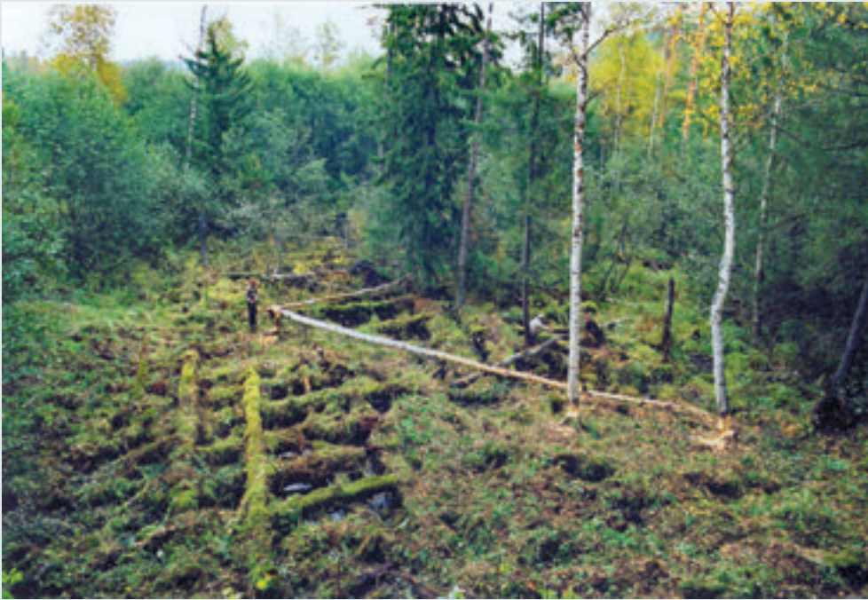
Свайно-реевое основание сливного моста
