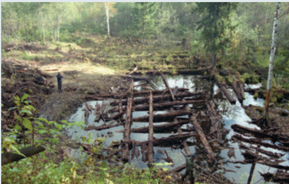
Свайно-реевое основание после расчистки
