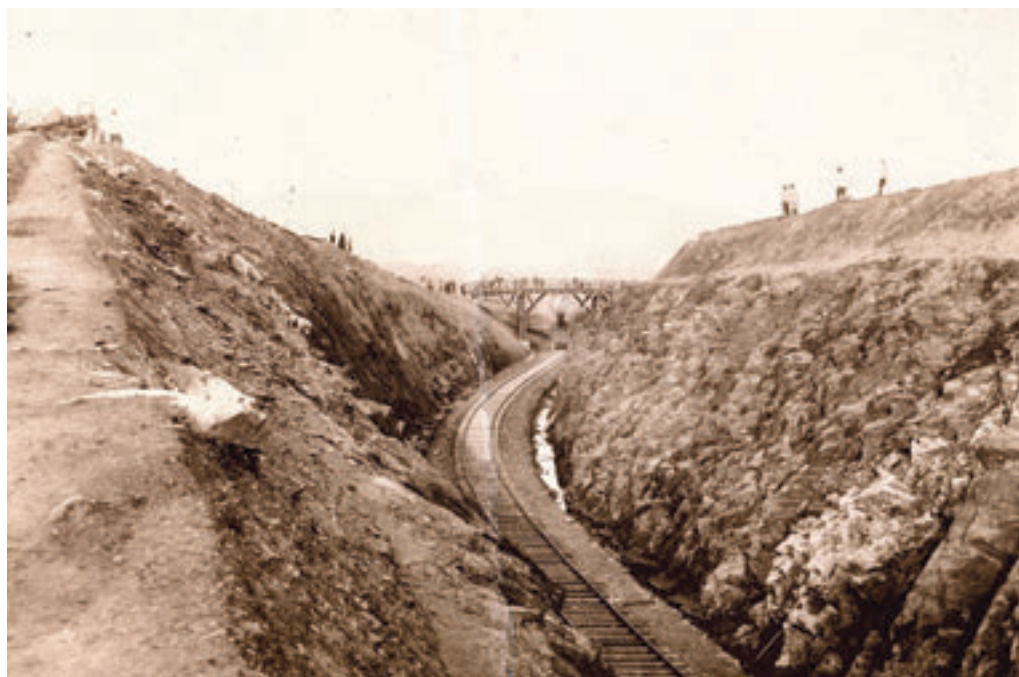
Выемка около Златоуста (железная дорога однопутная)
